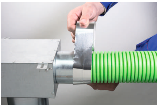
7) Spoj zajistíme vzduchotěsnou lepicí páskou.
