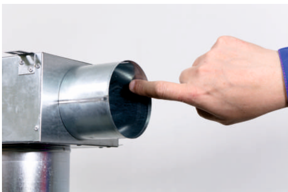
3) Vnitřní povrch vyústku namažeme kluzným přípravkem*.
